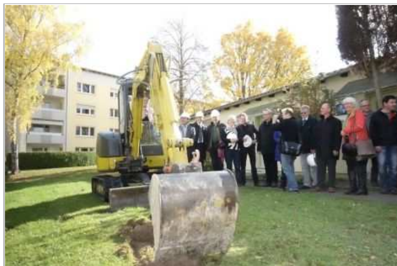
Symbolischer Baggerbiss: Barbara Bosch gibt den Startschuss für den Bau von 48 Wohnungen. GEA-FOTO: DÖRR
