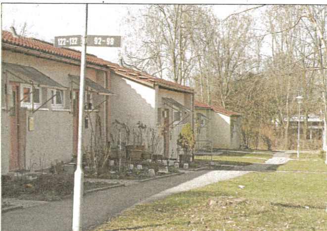
Diese kleinen Häuser sollen ersetzt werden. Im Bildhintergrund ist der städtische Sprachförderkindergarten (Heilbronner Straße 160) zu sehen. GEA-FOTO: DÖRR
