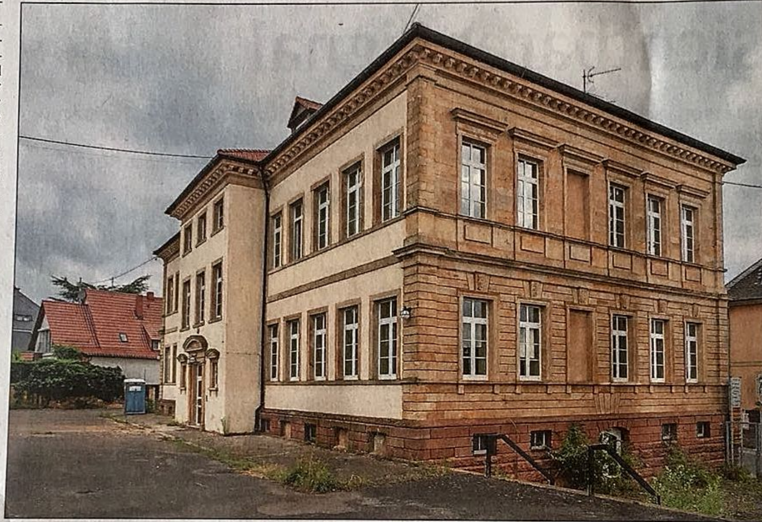
Die der Straße zugewandte Fassade der „Ludwigschule“ (rechts) soll in der historischen Form erhalten bleiben. An den anderen Gebäudeseiten wird Hand angelegt, um Balkone anzubauen.
