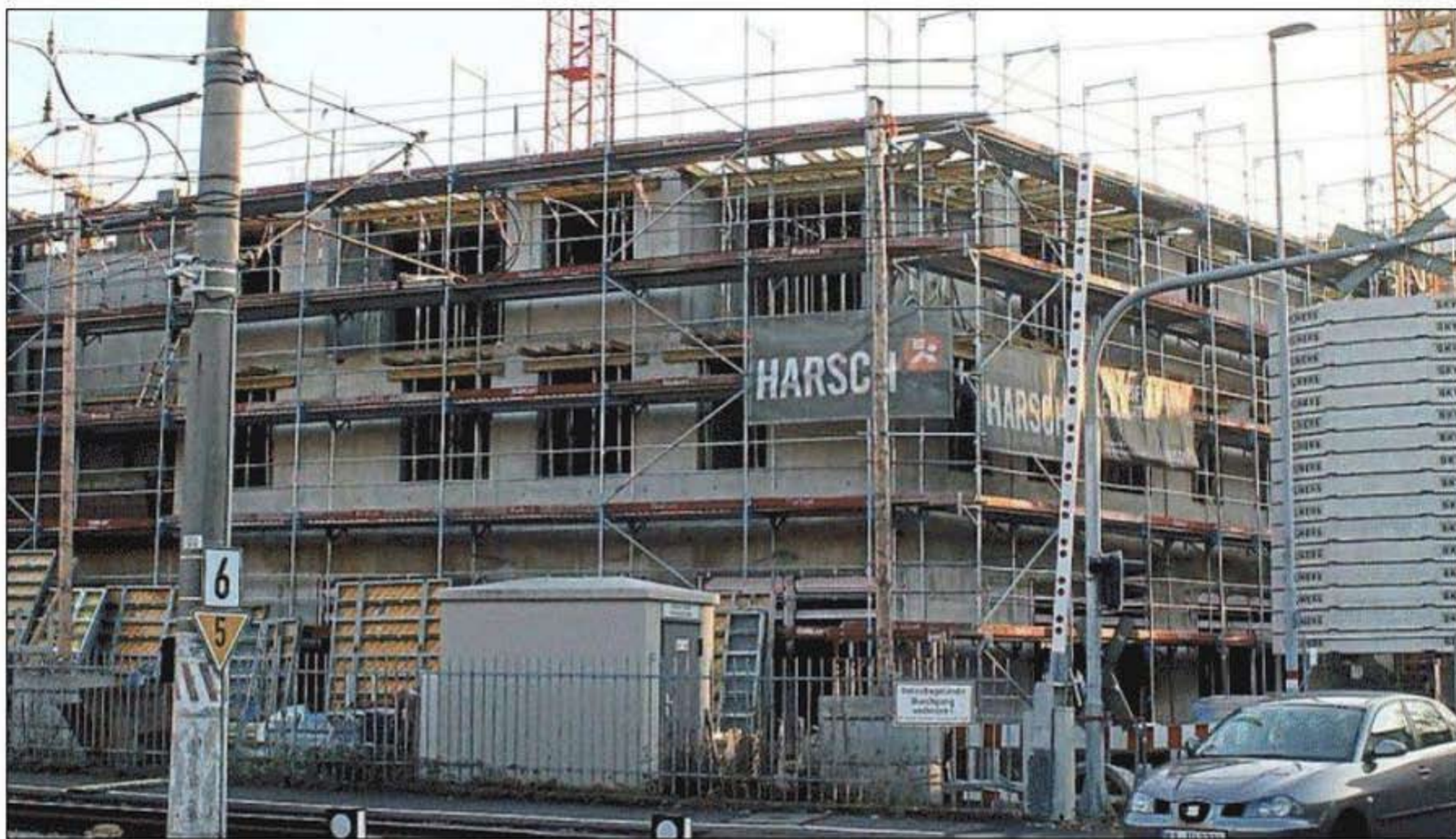
EIN BAUPROJEKT IN ETTLINGEN FÜR VERSCHIEDENE GENERATIONEN war im vergangenen Jahr der Neubau von Apartments auf dem Areal neben der Volksbank. Archivfoto: Klaus Müller
